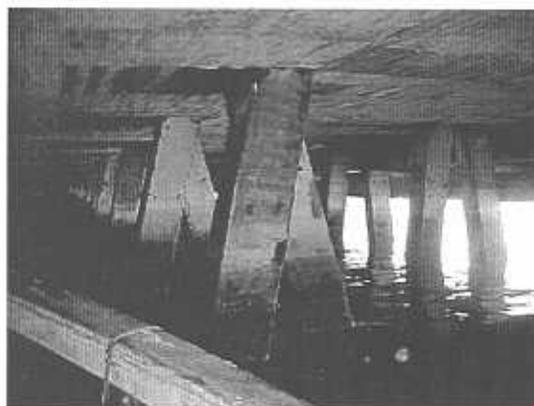
Figura 2. Disposición de pilotes
